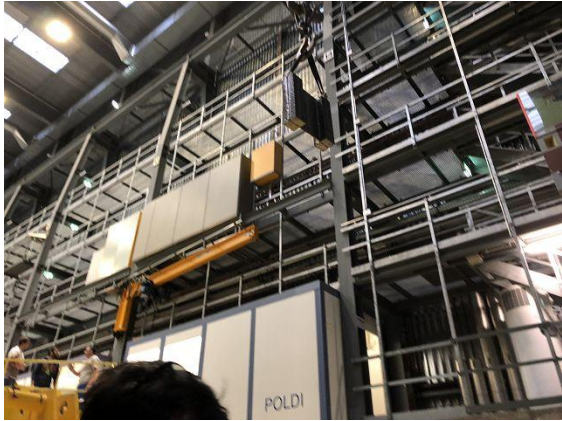
Bild 30: Die Teststücke können nur mit dem Kran dahin gebracht werden.
