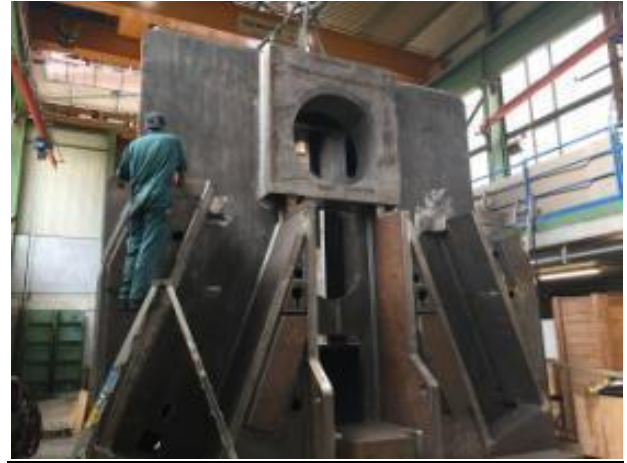
Photo 8 : Jim Widmer attachant les cordes de levage.
