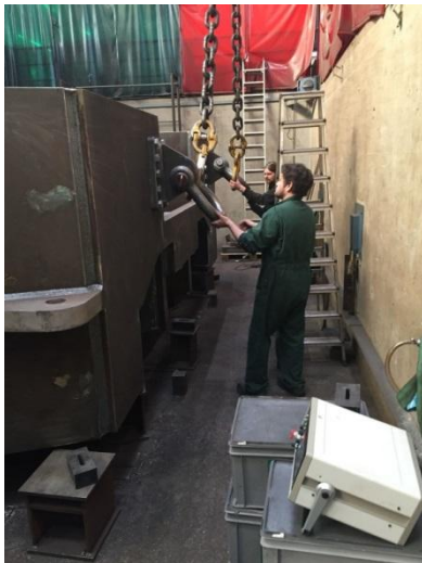
Immagine 11: Sven Widmer mentre prepara il componente da 60 tonnellate.
