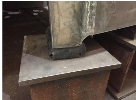
Bild 13: Hier wurde die 60 % der Gummiquetschung erreicht, mehr sollte gemieden werden.
